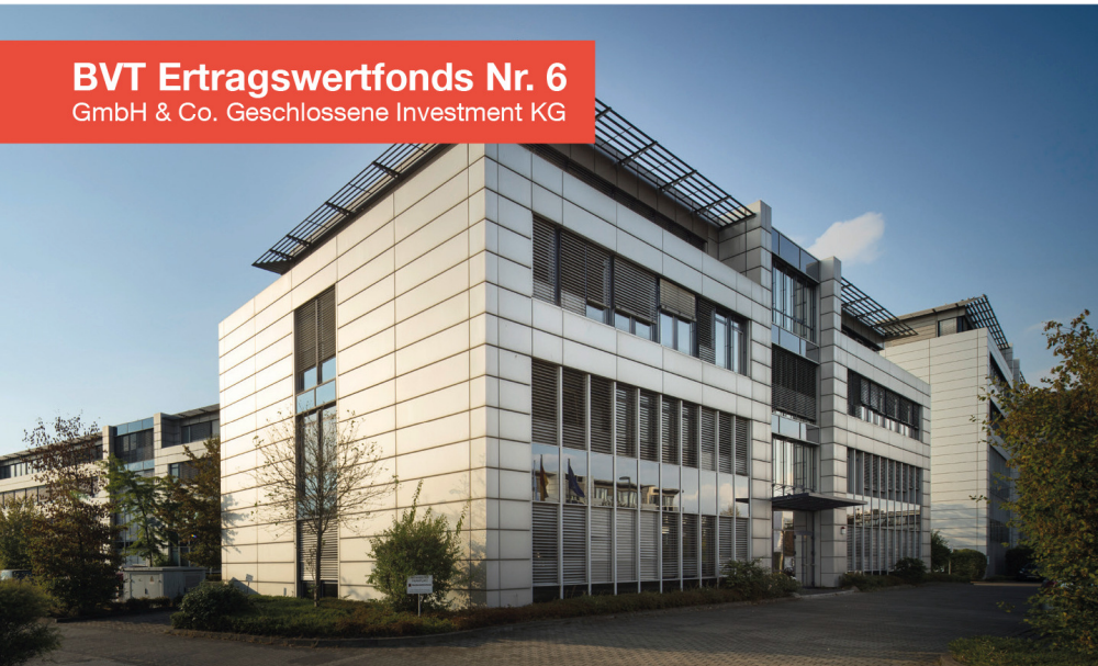
Fondsobjekt 1: Bürogebäude in Langenfeld, Kreis Mettmann, Nordrhein-Westfalen
